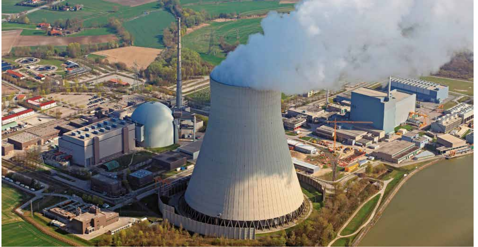
Die Tage sind gezählt: Auch das AKW Isar 2 soll zum Jahresende vom Netz genommen und in einen „Streckbetrieb“ überführt werden
