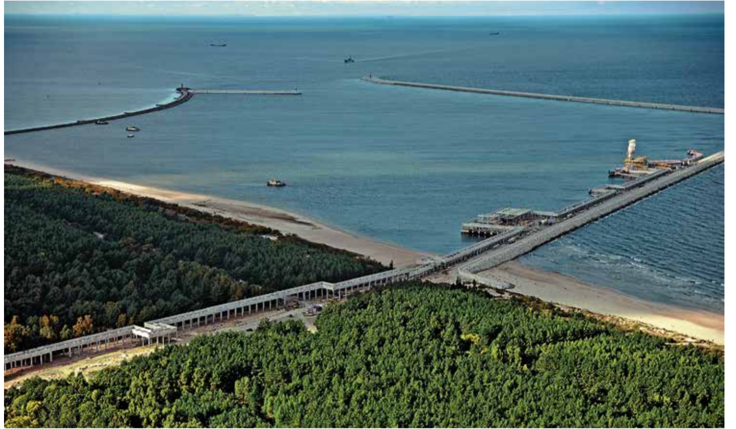
Der neue Hafen, in dem die LNG-Tanker anlegen, links ist die alte Mole zu sehen
