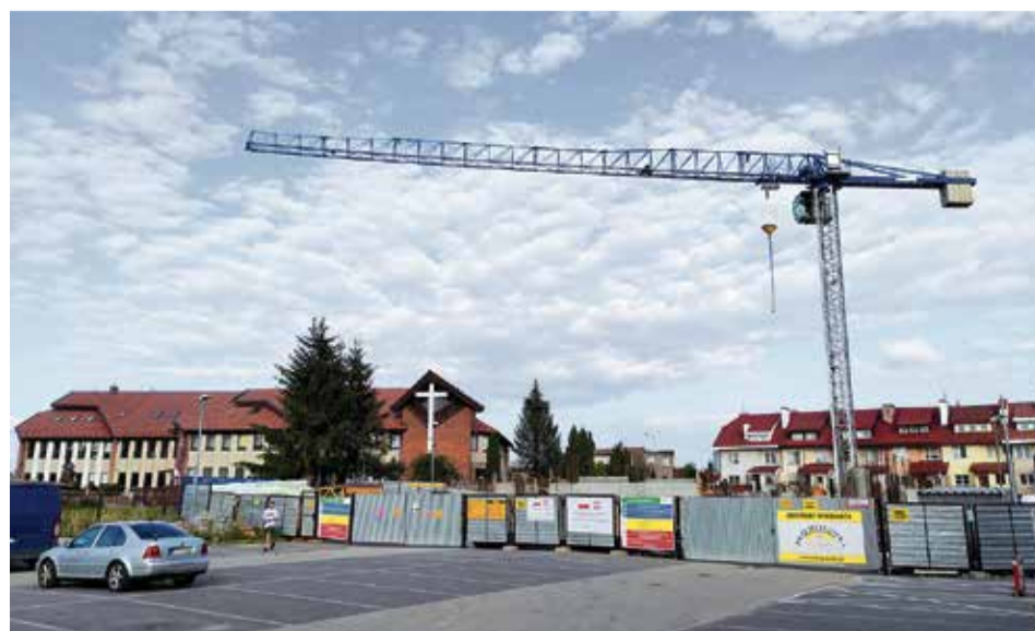
Bauarbeiten: Hier entsteht das Fecht- und Kulturzentrum
