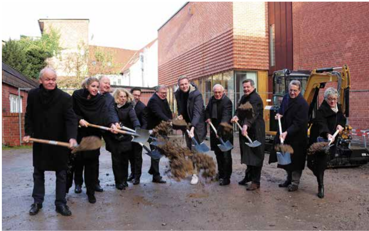
Startschuss für die Erweiterung: Die Vertreter von Bund, Land Niedersachsen und Stadt Lüneburg sowie von Landesmuseum und Ostpreußischer Kulturstiftung warfen mit Architekt Gregor Sunder-Plassmann symbolisch die erste Schaufel Erde für den Kant-Anbau
