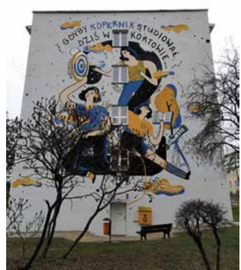
Fassade des Studentenwohnheims
