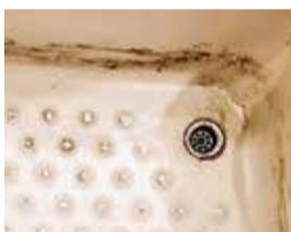
Eigenreparatur einer Wohnmobilmwanne, die nur kurze Zeit hielt
