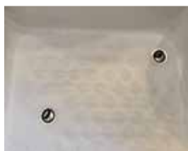
Nachher sieht dieselbe Duschwanne wie neu aus nach Fromms Reparatur
