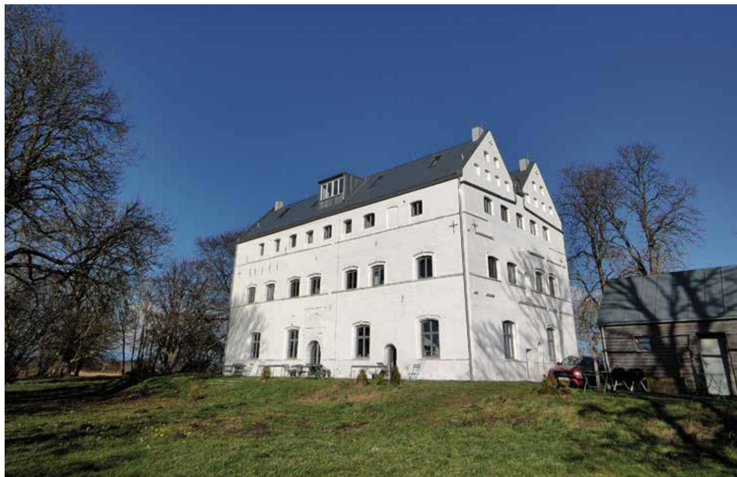
Die Südwestansicht des Herrenhauses Üselitz
