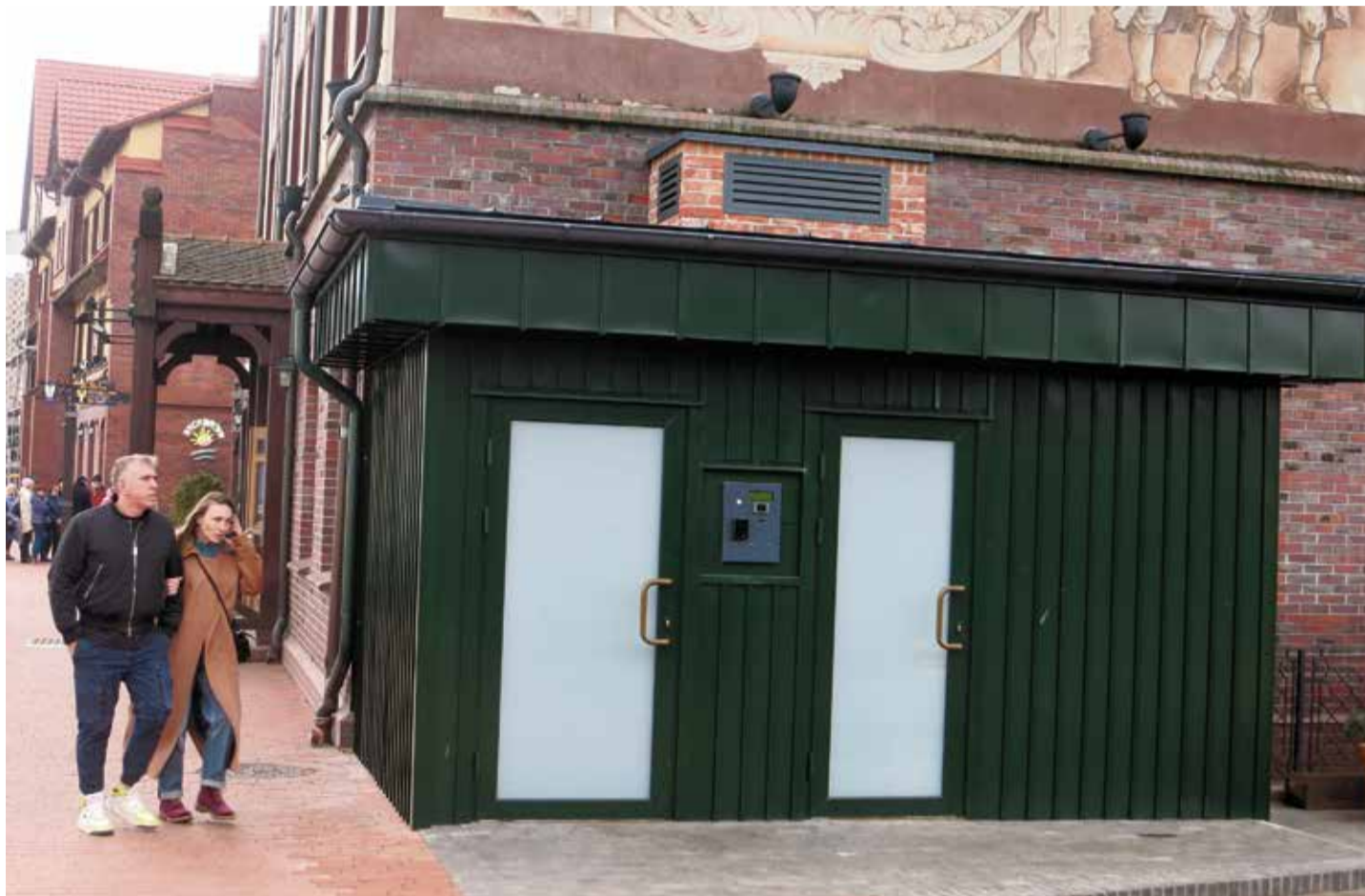
Umstrittener Anbau: Statt Toiletten in den Neubau zu integrieren, stellte der Bauherr einen hässlichen Container auf Foto: J.T.
