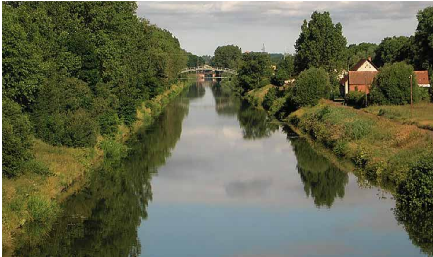
Der von Brenkenhoff gebaute Bromberger Kanal – auf dem rechten Ufer die Überbleibsel der Kanal Kolonie A
