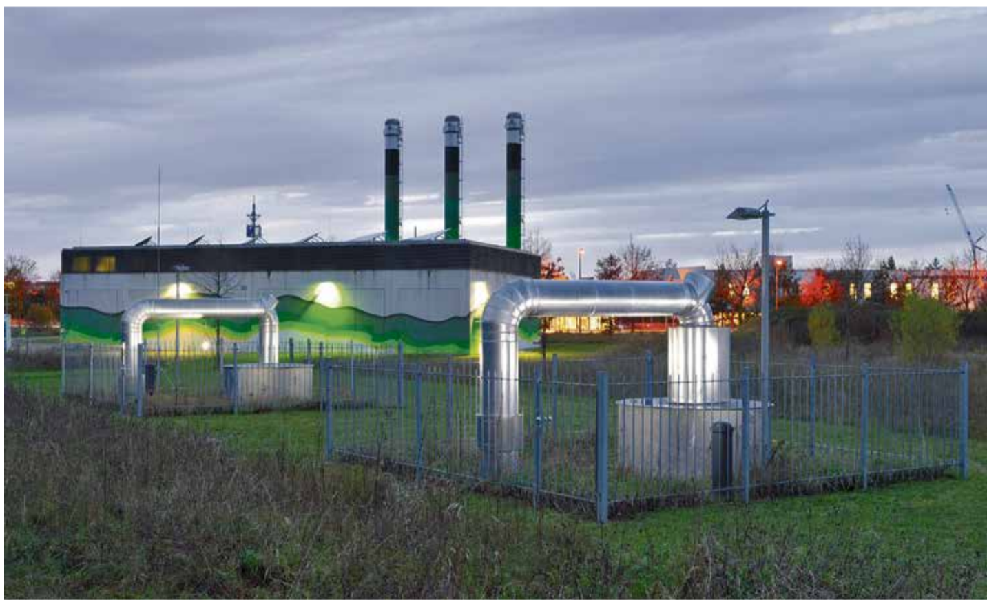
Im Gegensatz zu Windkraft- und Photovoltaikanlagen ziemlich dezent: Erste Geothermieanlage der Stadtwerke München (SWM) in München-Riem Foto: SWM/Thomas Einberger
