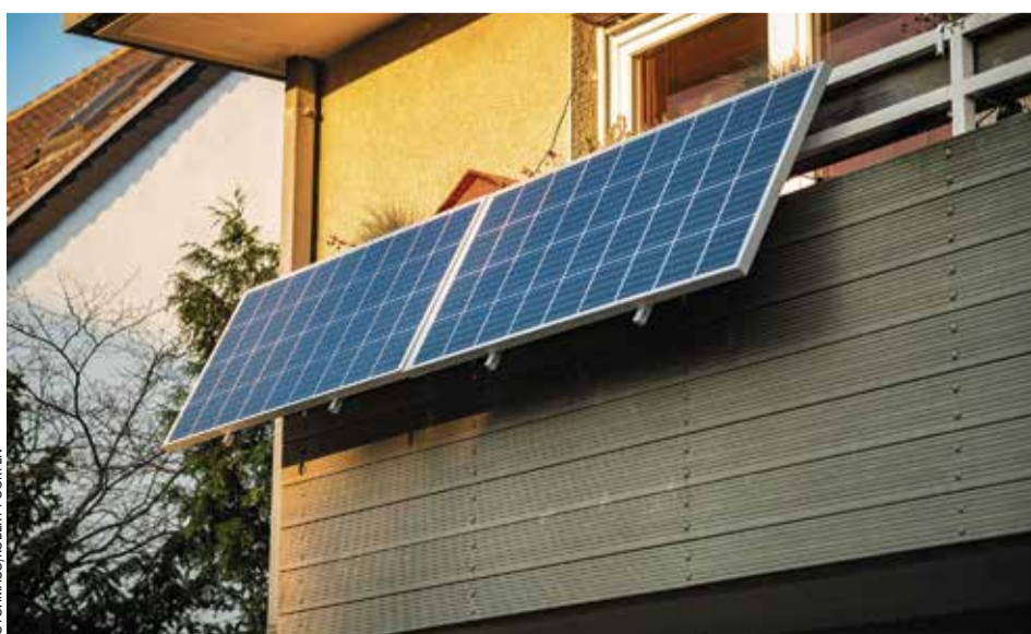
Sichtschutz und Energielieferant in einem: Solaranlage an einem Balkon
