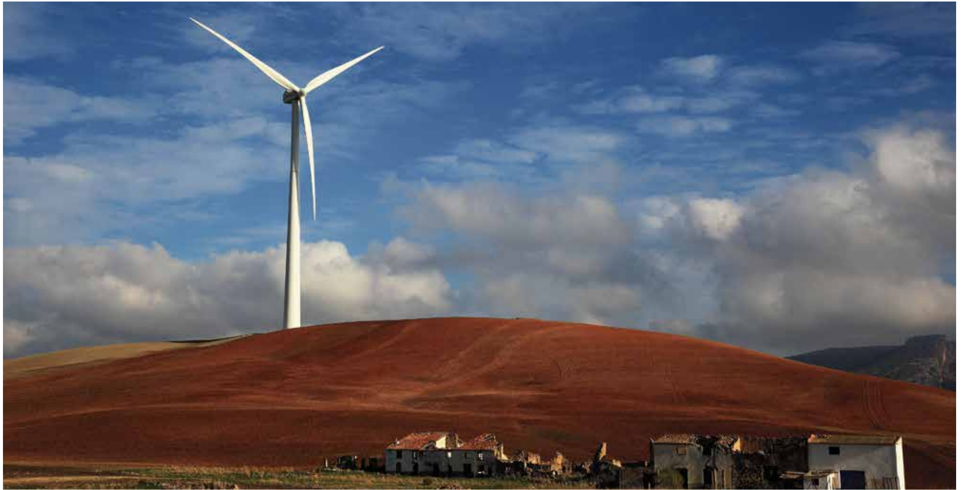
„Es gibt kaum eine effizientere Beeinflussung des lokalen bis regionalen Klimas“: Windkraftanlage in Andalusien
