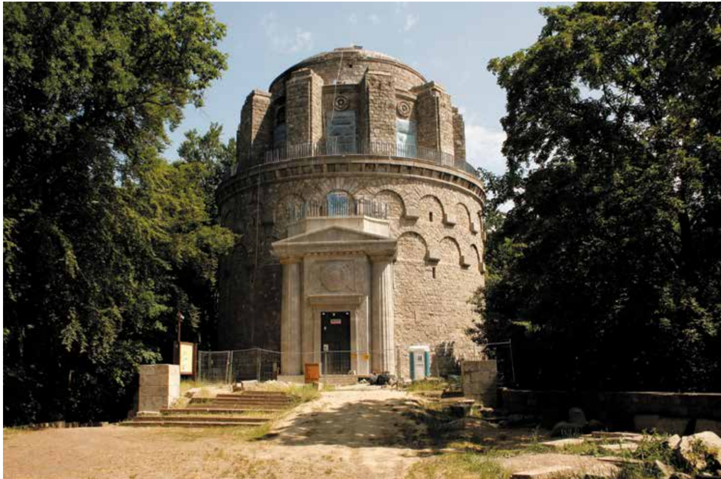
Der Bismarckturm auf dem Juloberg in Stettin-Gotzlow: Nachdem das Gebäude jahrzehntelang im Dornröschenschlaf schlummerte und dem Verfall preisgegeben war, kümmert sich nun ein Stettiner Unternehmer um seine Rettung. Inzwischen wurde bereits das Eingangsportal erneuert Foto: Engel
