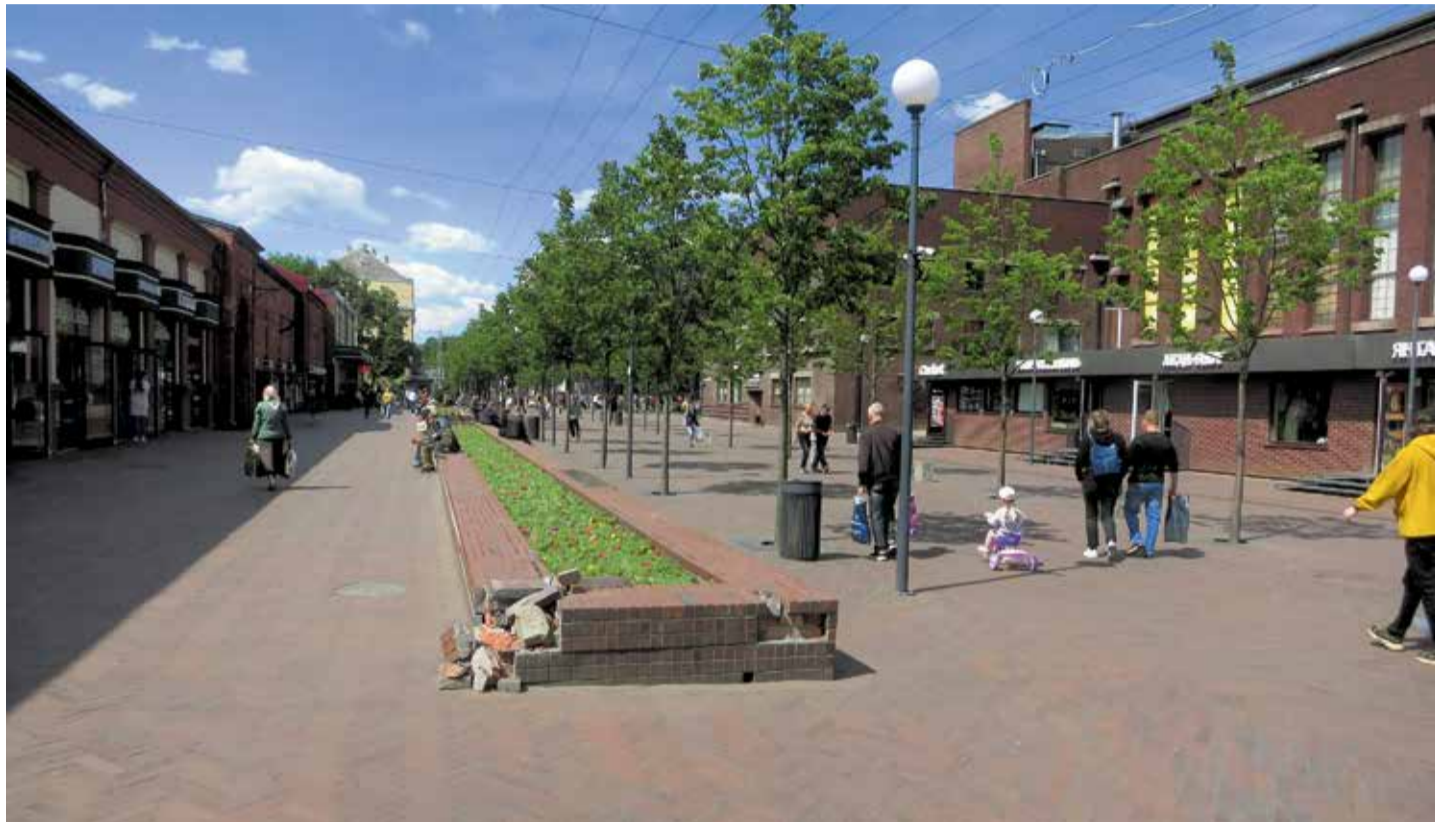
Fehlende Parkplätze, limitierte Warenlieferung, marode Bauten: Die Fußgängerzone bröckelt an vielen Stellen
