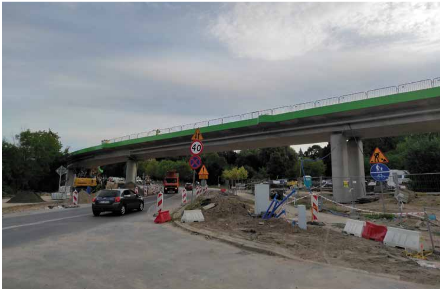
Hier soll bald eine Straßenbahn verkehren: Bau einer Brücke in Allenstein
