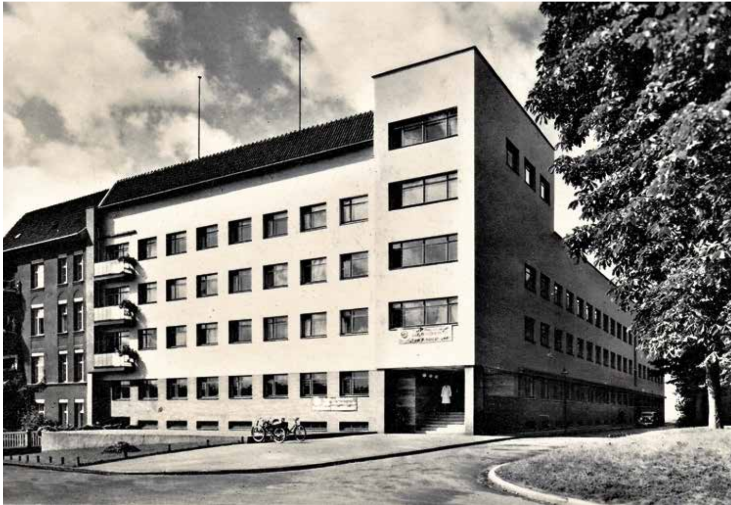
Zeugnis für die Schaffensphase des deutschen Architekten Hanns Hopp in Ostpreußen: Das Funkhaus der Ostmarken AG in Königsberg
