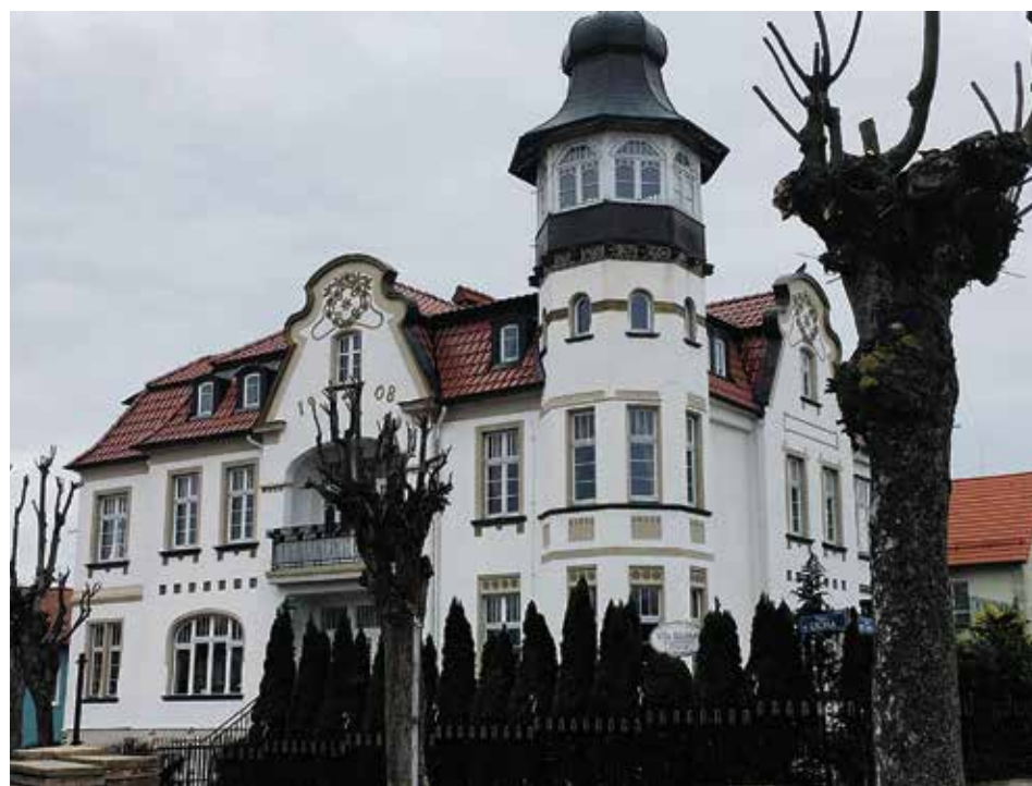
Die „Villa Richter“ in Misdroy: Ein echtes Juwel der Jugendstil-Architektur, erbaut 1908 an der Westendpromenade. Auch heute bietet das Haus komfortable Apartments in exponierter Lage
