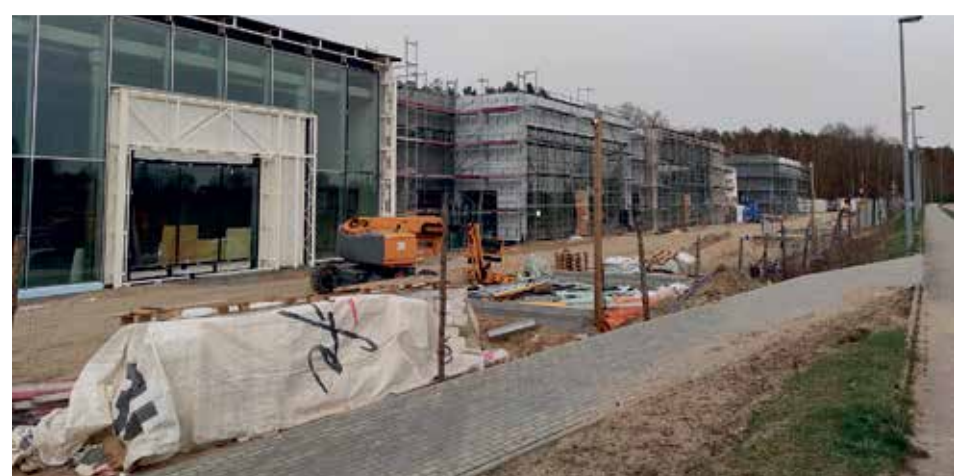
Bauarbeiten sind in vollem Gang: Entstehendes Einkaufszentrum in Deuthen
