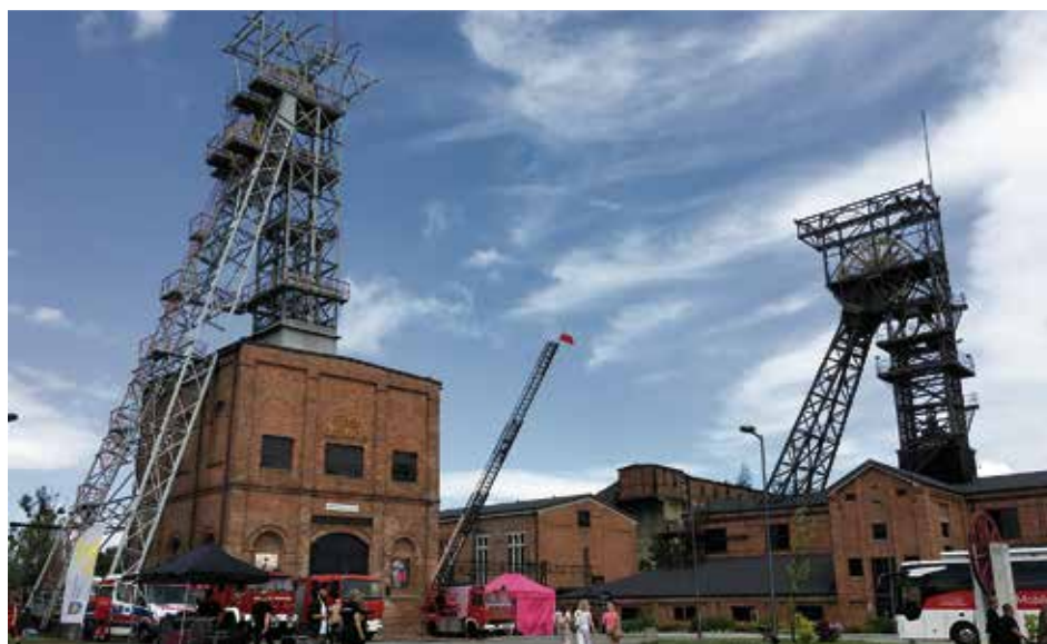
Nach liebevoller Sanierung: Ehemalige Hoymgrube in Rybnik
