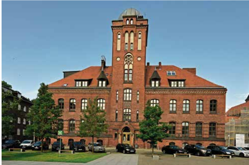
Im Turm des alten Physikalischen Instituts, das 1891 auf dem historischen Campus der Greifswalder Universität erbaut worden war, befindet sich die Sternwarte.
