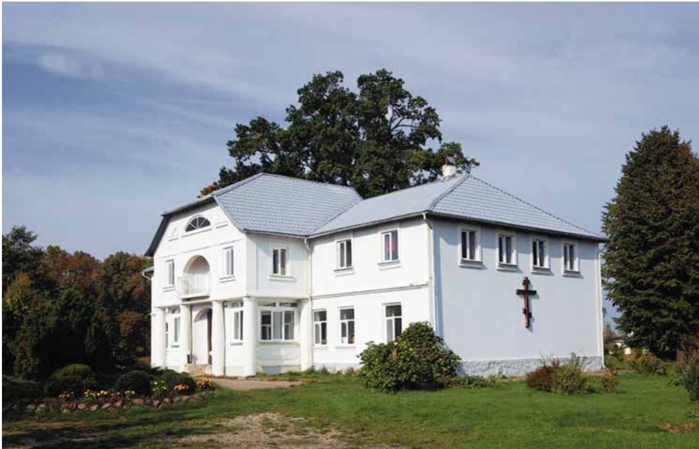
Auf dem idyllischen Gelände eines Deutschen Gutshauses Dedawe/Deimehöh: Hier entstand im Jahr 2000 ein russisch-orthodoxes Nonnenkloster, wobei das eigentliche Gutshaus seither als Gästehaus für Pilger fungiert Foto: Screenshot Yandex
