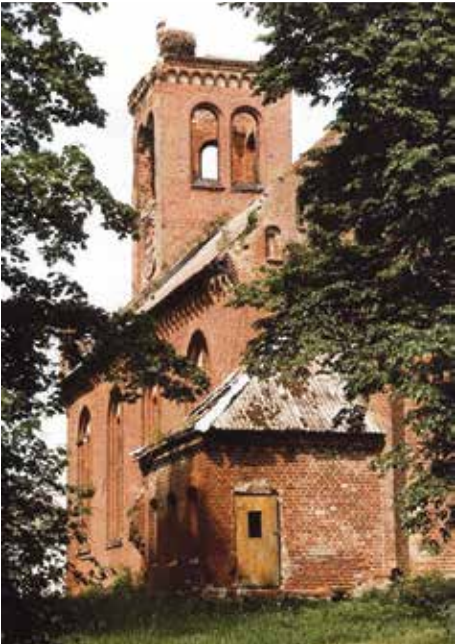
Heute ist das Gotteshaus nur noch eine Ruine Foto: Marieta Waldszus
