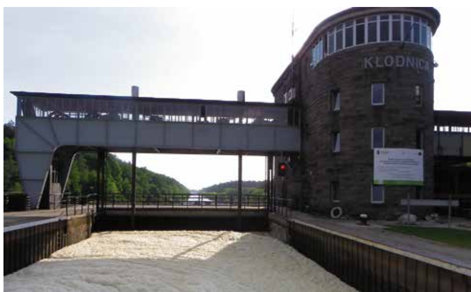
Sauerstoffarmes Wasser: Klodnitzer Schleuse kurz vor der „Mündung“ des Gleiwitzer Kanals in die Oder Foto: Wagner
