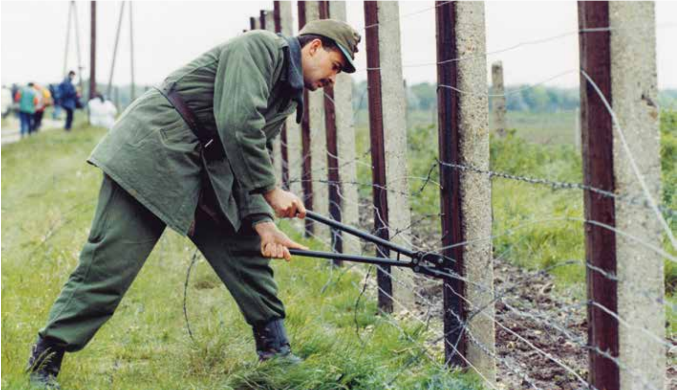
Ende des Eisernen Vorhangs: Ende April 1989 begann Ungarn, seine scharf gesicherten Grenzanlagen zu Österreich abzubauen. Im Bild Demontagearbeiten bei Hegyeshalom (Ungarn) am 2. Mai 1989
