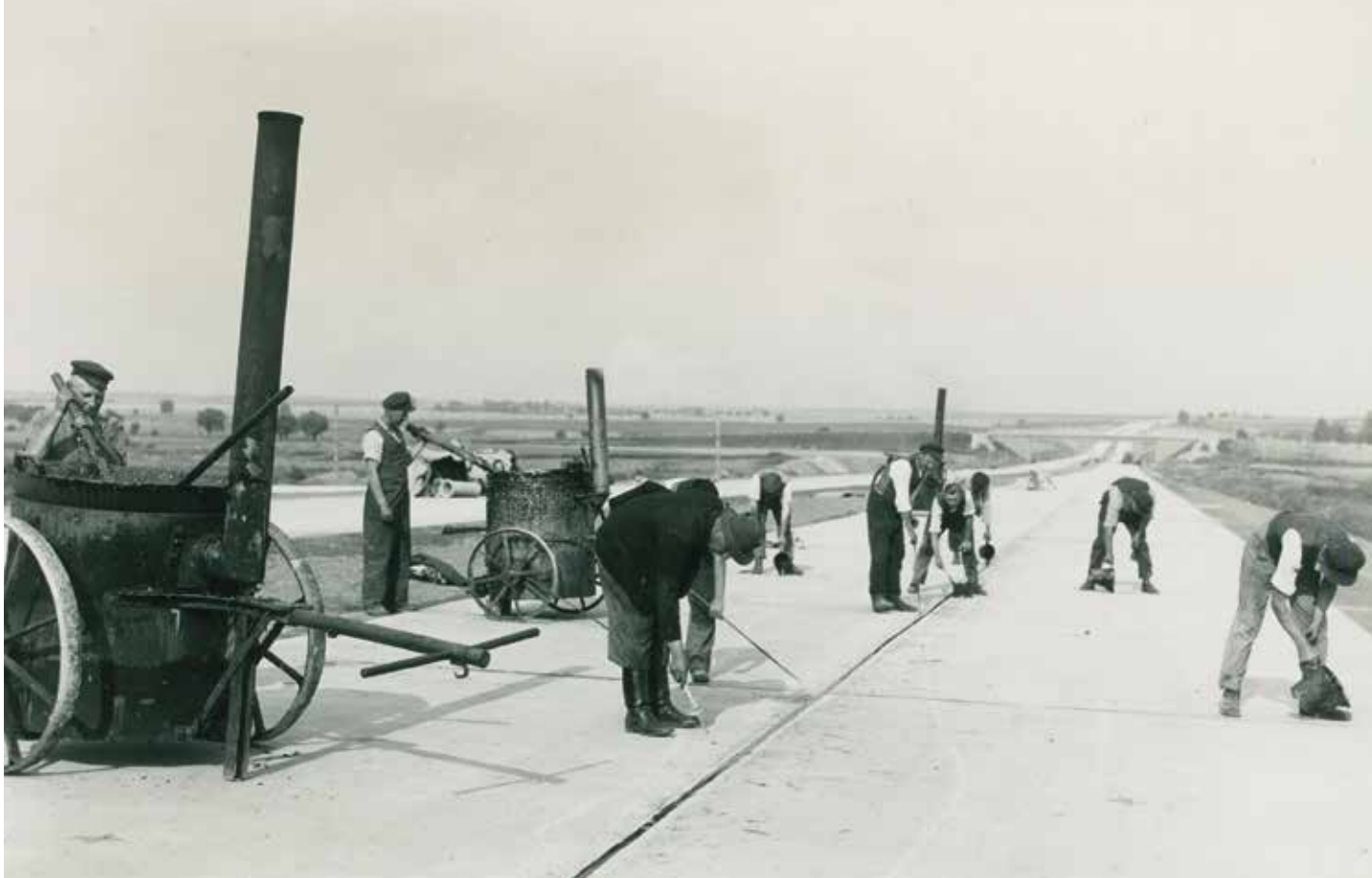
Bauarbeiten an der Reichsautobahn Berlin - Königsberg: Im Bild der Abschnitt Berlin-Stettin, bei Penkun, wo Arbeiter 1936 die Fahrbahndecke herstellen und die Fugen mit Teer befüllen Foto: akg images / holzmann-bildarchive.de/HDB
