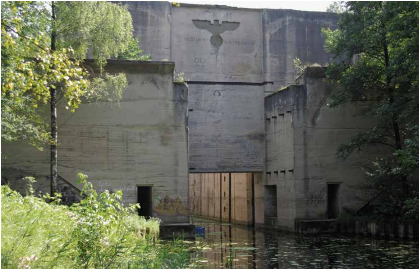
Einige Schleusen, wie hier die Oberschleuse Fürstenau, wurden über die Jahre hinweg bis 1944 noch fertiggestellt, aber letztendlich blieb der komplette Kanal unvollendet, weil die Sowjetunion die Anlagen als Reparatur einbehielten Foto: Janericloebe/Wikipedia
