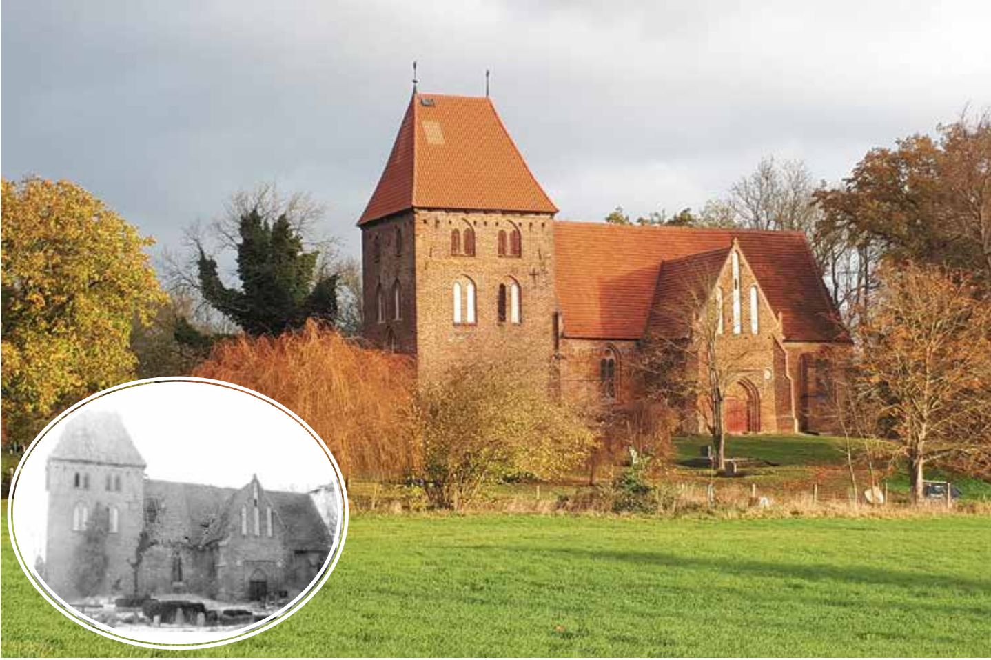
Vor wenigen Dekaden eine zerfallene Ruine, jetzt aber größtenteils saniert: Die Johanniter-Kirche zu Großen Eichsen Foto: Püstov
