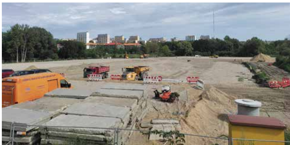
Am Rand Allensteins: Baustelle für das Gebäude der Möbelkette
