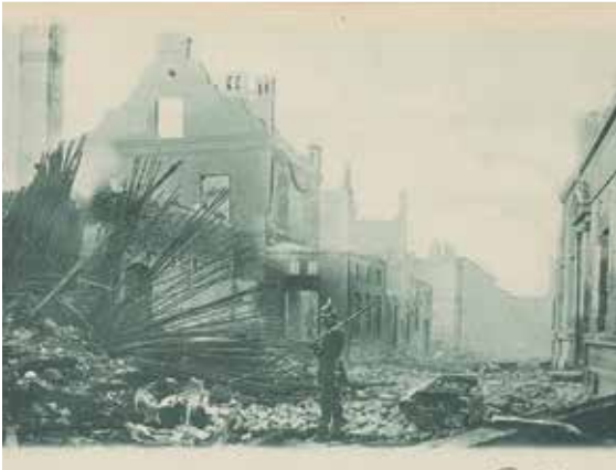
Der große Brand am 26. Juli 1899 – zu sehen sind die gewaltigen Schäden, welche der erste von drei Bränden in diesem Sommer verursachte
