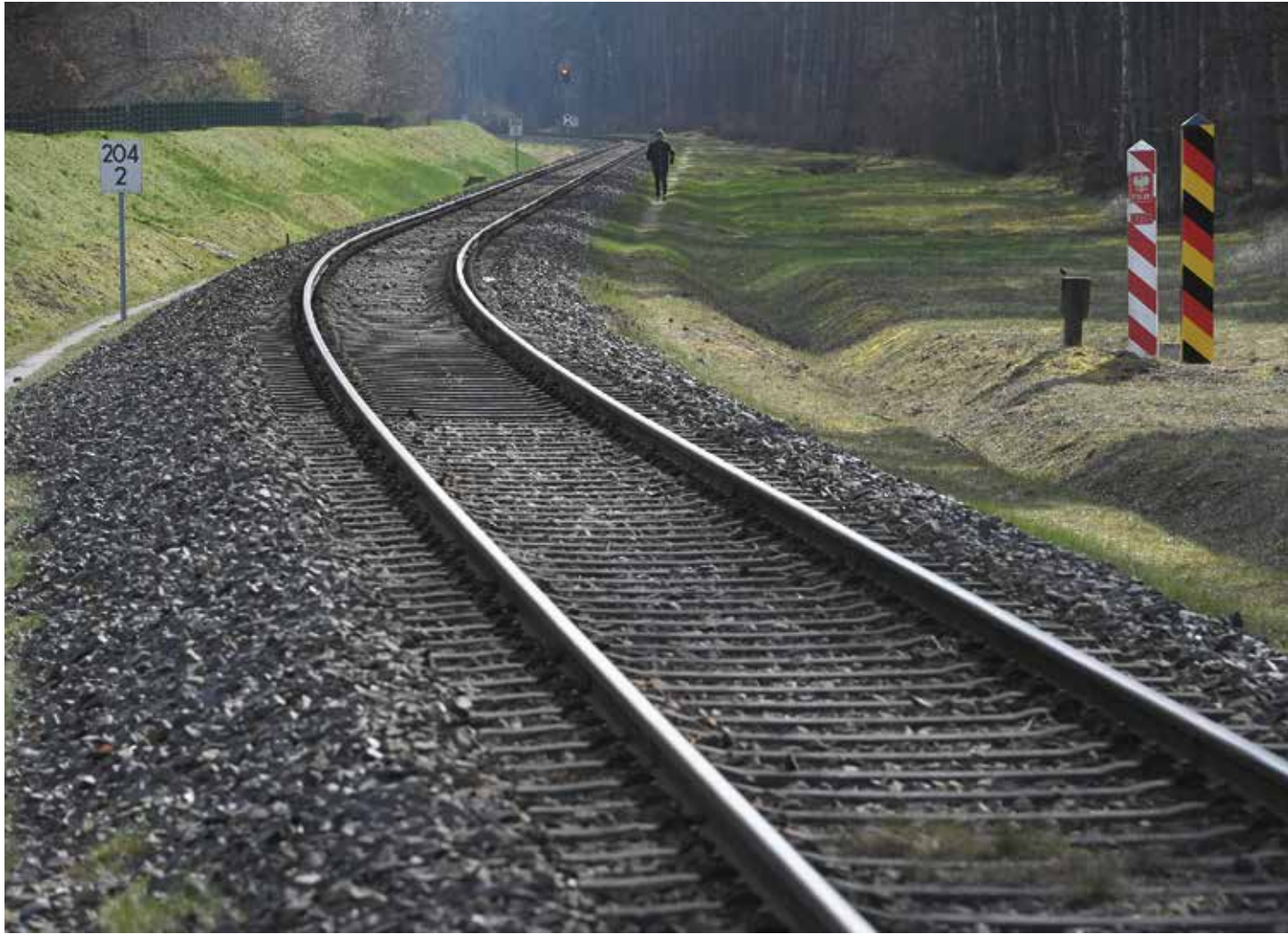
Die antiquierte Bahnstrecke von Berlin nach Küstrin: Eingleisig, ohne Oberleitung und soll erst bis 2045 voll modernisiert werden
