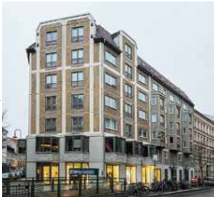
Denkmalgeschützte Platte: Weinmeisterstraße/Neue Schönhauser Straße 1
