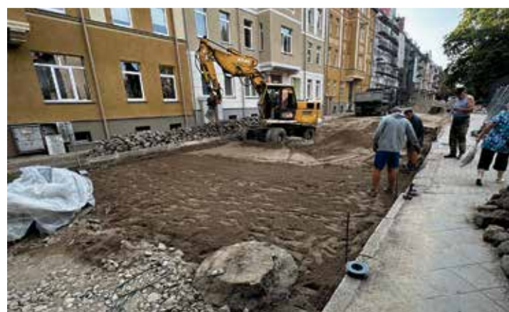
Anlehnung an historische Ansichten: Straßenarbeiten an der Jordanstraße in Insterburg (l.), und die Straße, wie sie früher einmal ausgesehen hat
