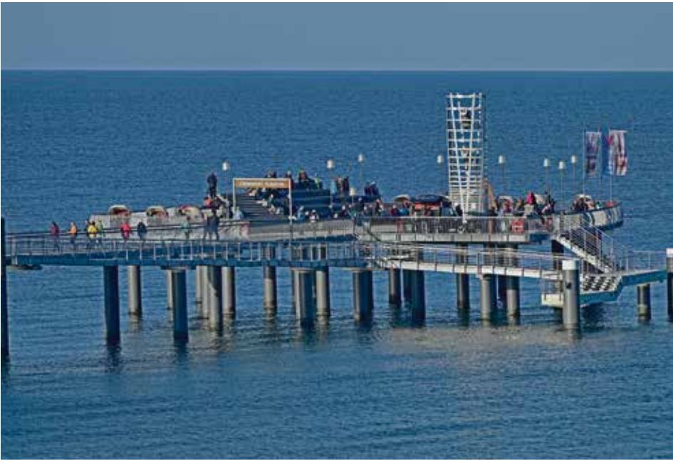
Außergewöhnlich: Den Brückenkopf der Koserower Seebrücke bildet eine Veranstaltungsplattform mit einem Glockenturm, dessen Geläut an die versunkene Stadt Vineta erinnern soll
