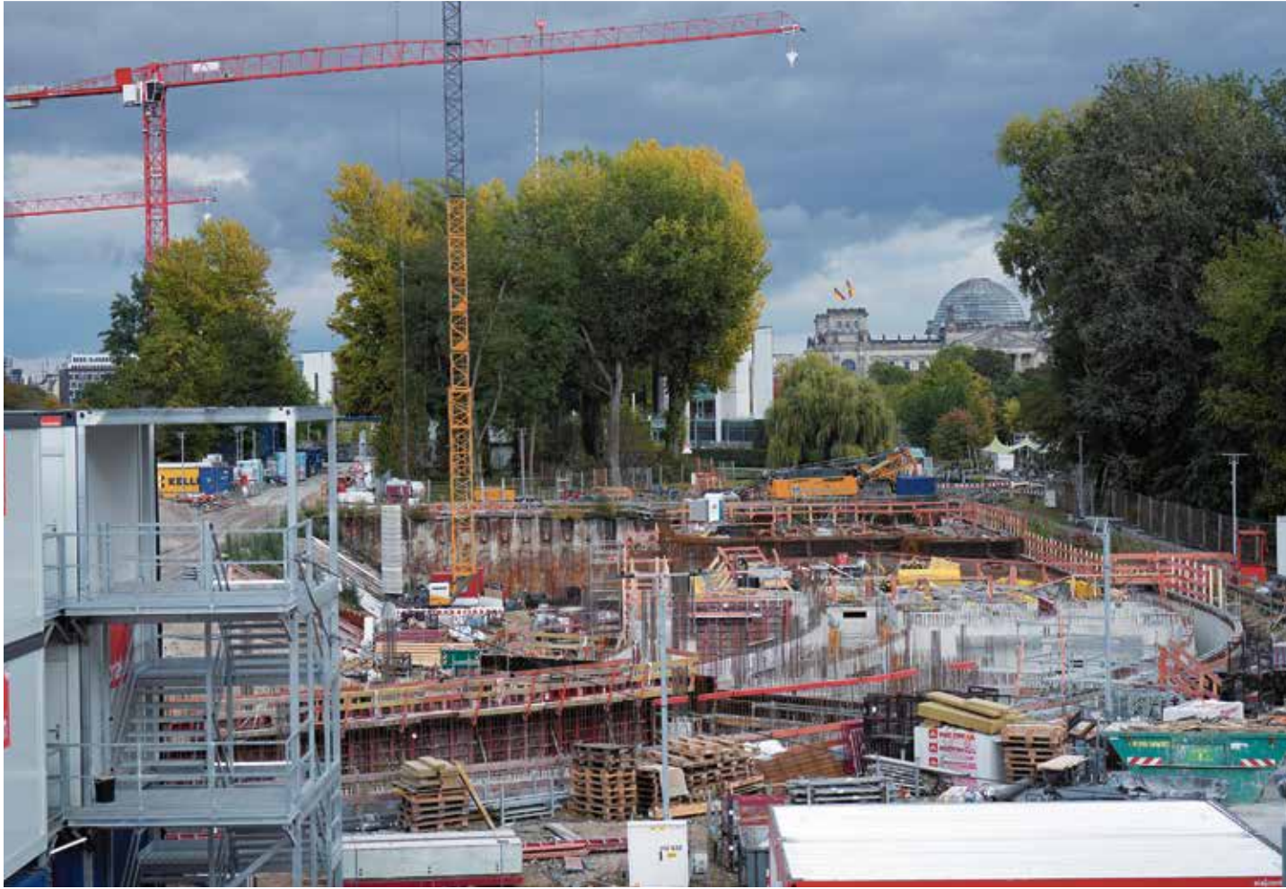
Kosten könnten sich mehr als verdoppeln: Erweiterungsbaustelle des Kanzleramts Anfang Oktober
