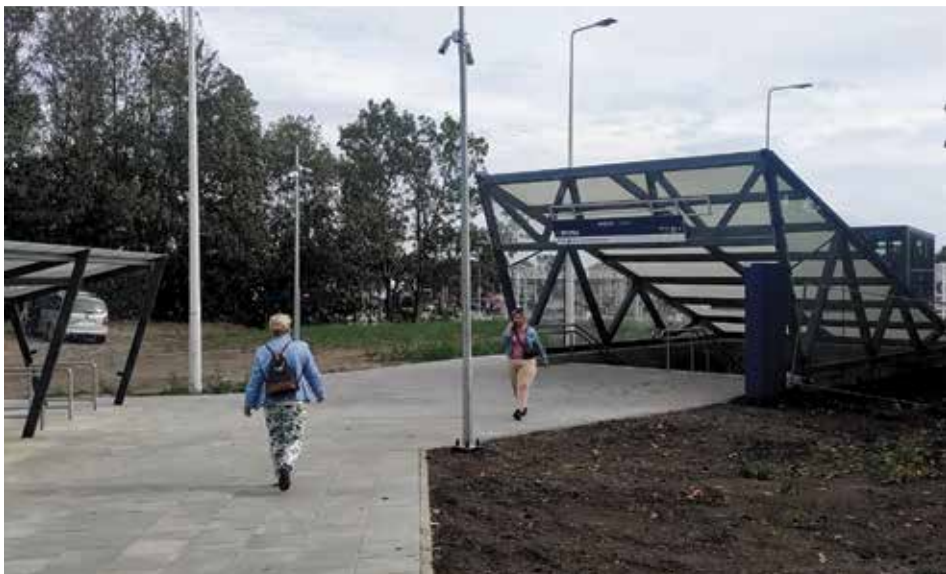
Umbauten im Bahnhofsbereich: Der neue Zugang zu den Bahnsteigen
