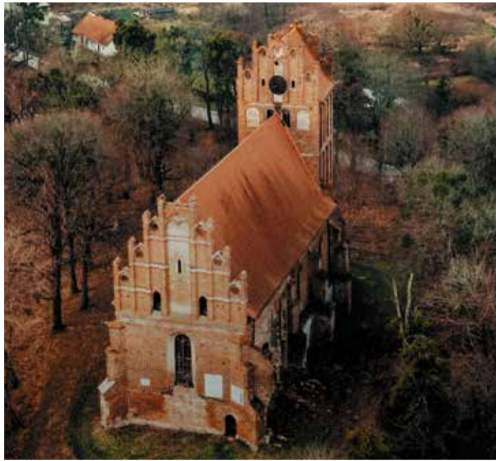
Kirche Friedland heute und damals: Dank der „Ruinenwächter“ konnte der weitere Verfall der Ruine gestoppt werden (l.), rechts im Bild das Gotteshaus im Winter vor dem Krieg
