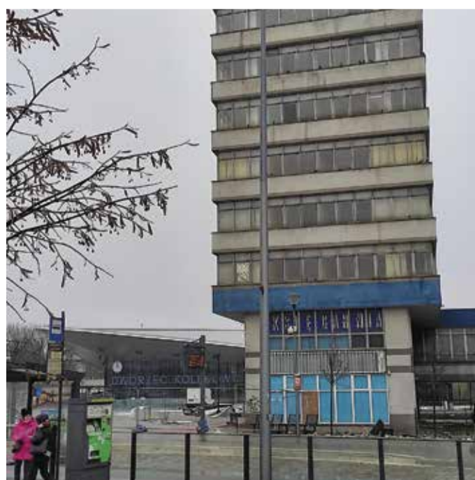
Als Schandfleck in der Stadt empfunden: Ruine eines Bürogebäudes vor dem Neubau des Allensteiner Bahnhofs
