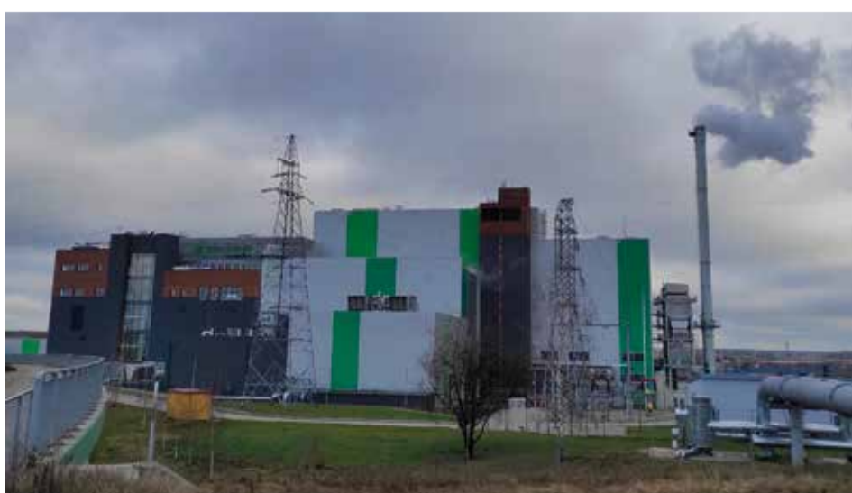
Alenstein: Die neue Anlage in den östlichen Stadtteilen
