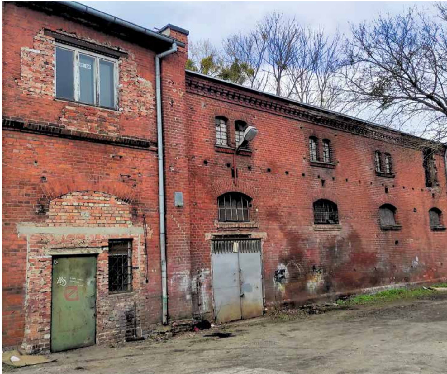
Wartet auf seine Sanierung: Gebäude der ehemaligen Dragonerkaserne
