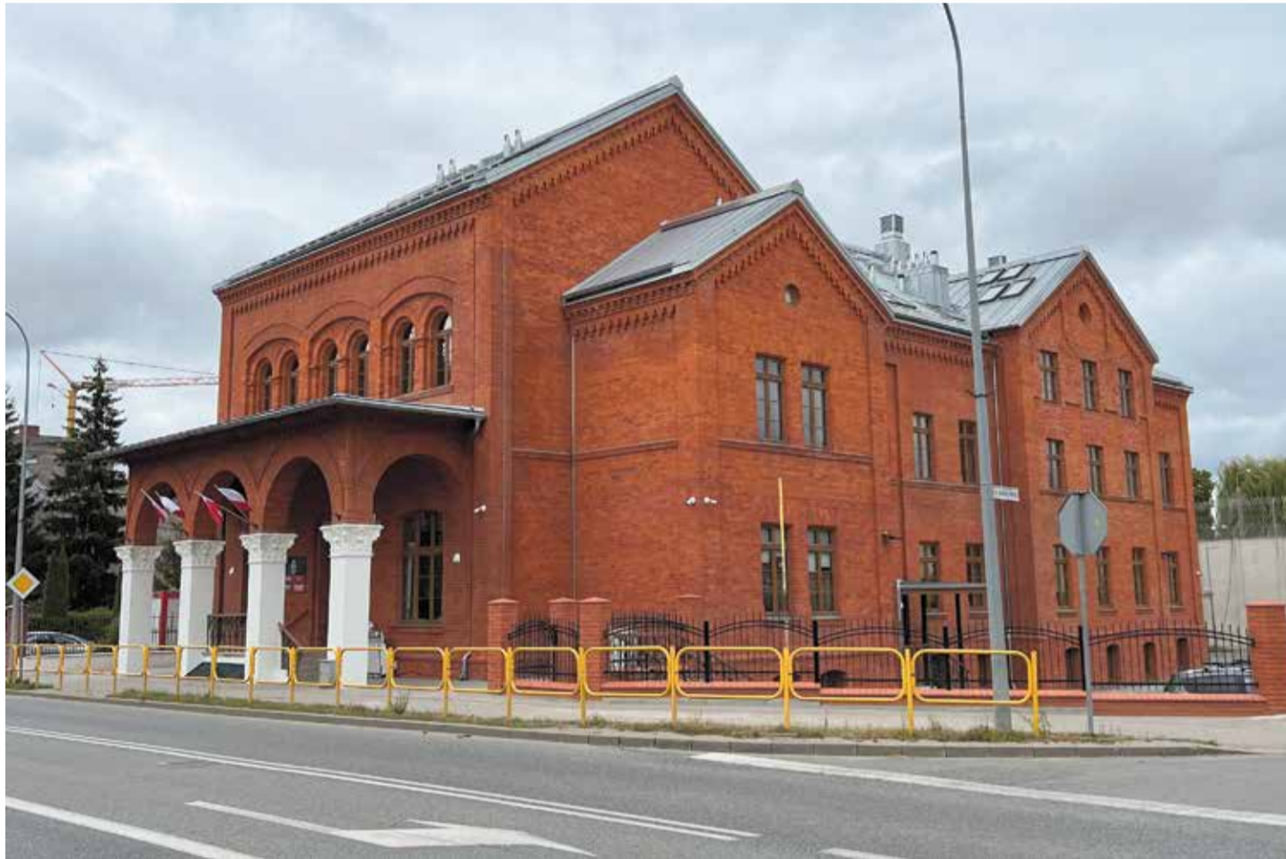
Im Jahre 2022: Das ehemalige Gebäude des Amtsgerichts Bartenstein
