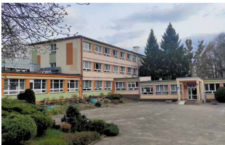
Schule für hörgeschädigte Kinder: Hier entsteht das neue Kinderschutzzentrum
