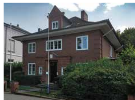
„Haus Stettin“, Huxterdamm 18 a, 23522 Lübeck Foto: Suda
