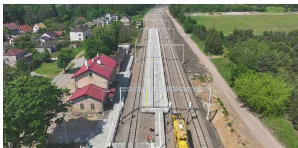
Fertiggestellter Teilabschnitt: Gleisanlage beim Bahnhof Alt Jucha
