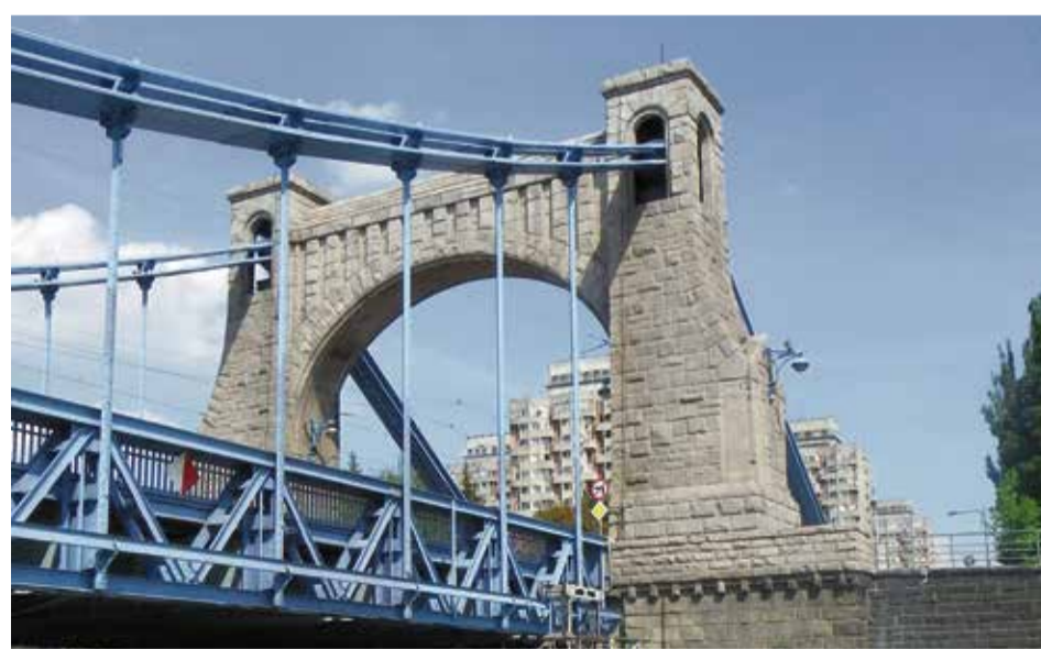
Löst bei manchen heftige Emotionen aus: Nach der Sanierung soll die deutsche Inschrift auf die Kaiser-Wilhelmbrücke in Breslau zurückkehren
