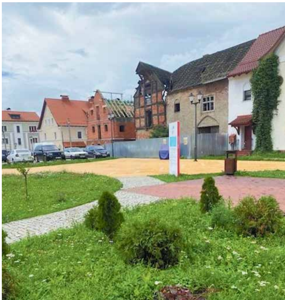
Alte, baufällige Häuser neben bereits fertiggestellten Fassaden und Dächern: In Gerdaunen wird allorten restauriert und renoviert Bild: Beutner
