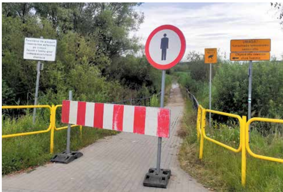
Wegen Überflutung gesperrt: Der beliebte Radweg Lynostrada
