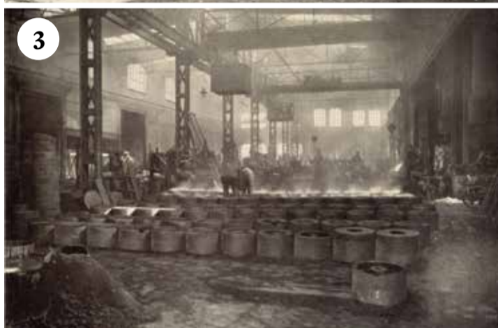
1. Ein Güterwagen aus dem Jahr 1920, 2. Im Hammerwerk wurden die Teile zurechtgehämmert, 3. in der Gießerei wurden in den Formen die einzelnen Metallteile hergestellt, 4. Eisener Durchgangswagen Klasse 3 aus dem Jahr Bild: Bildarchiv Ostpreußen
