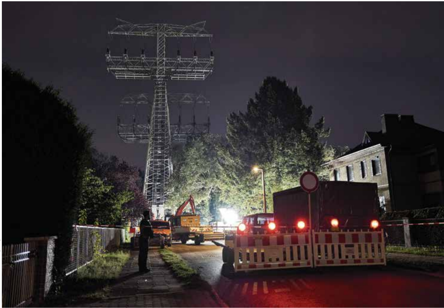
Wegen eines Brandanschlags auf zwei Strommasten in Berlin waren 43.000 Haushalte und 3000 Firmen tagelang ohne Strom
