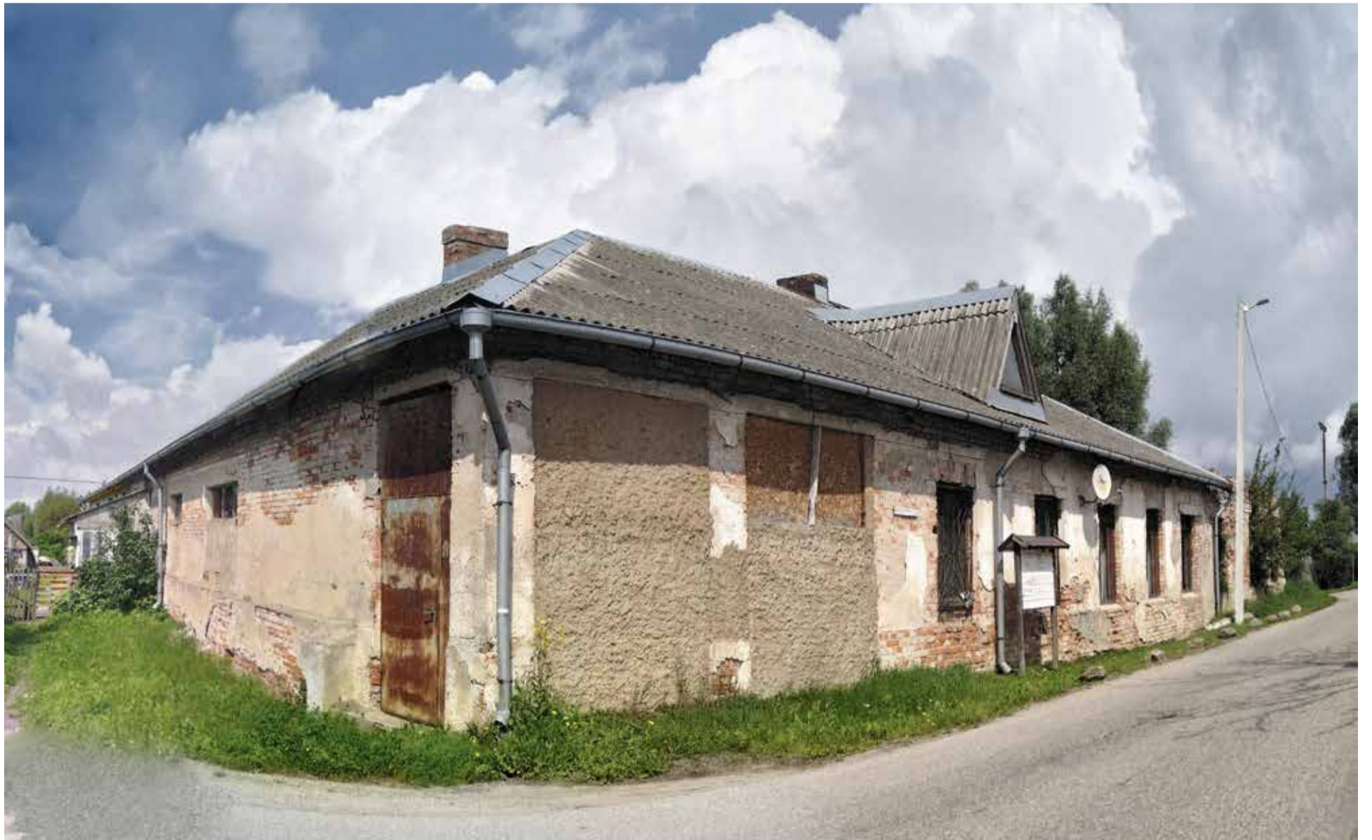
Verfallener Zeuge eines einstigen architektonischen Schmuckstücks von Stararchitekt Bruno Möhring: Das Gasthaus in Juwendt
