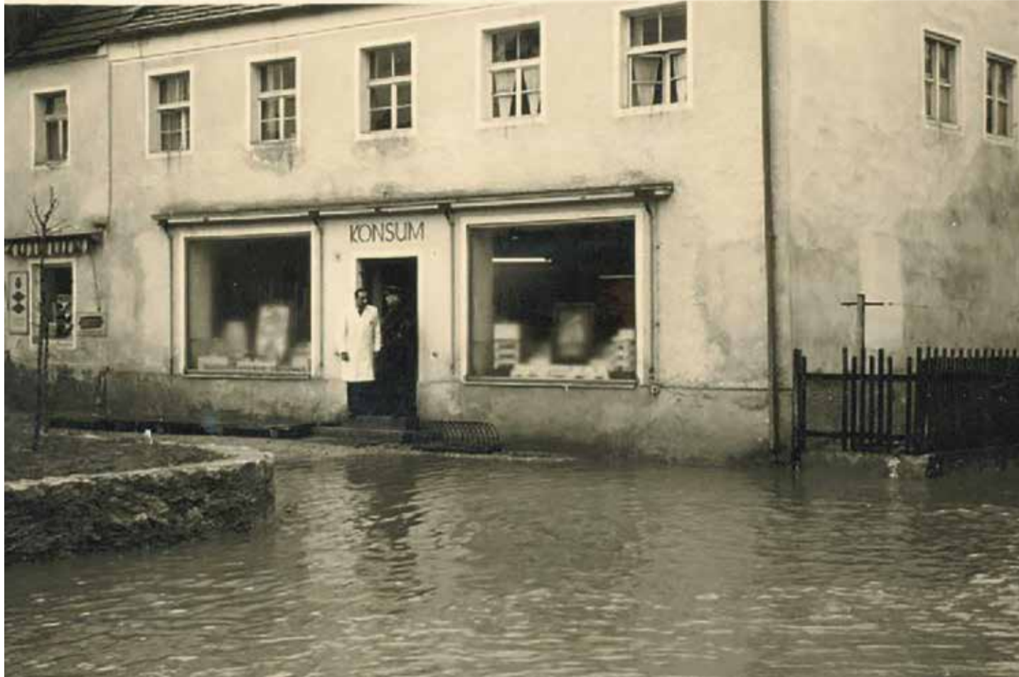
Land unter am Konsum: Der Lebensmittelladen in Beratzhausen in den 50er Jahren während eines Hochwassers
