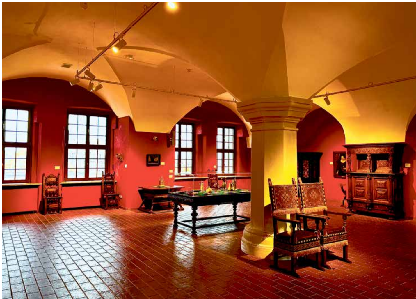
Im Nordflügel des Schlosses: Diese Säule im Elisabethanischen Saal sackte ab und wurde in achtjähriger Bauzeit saniert
