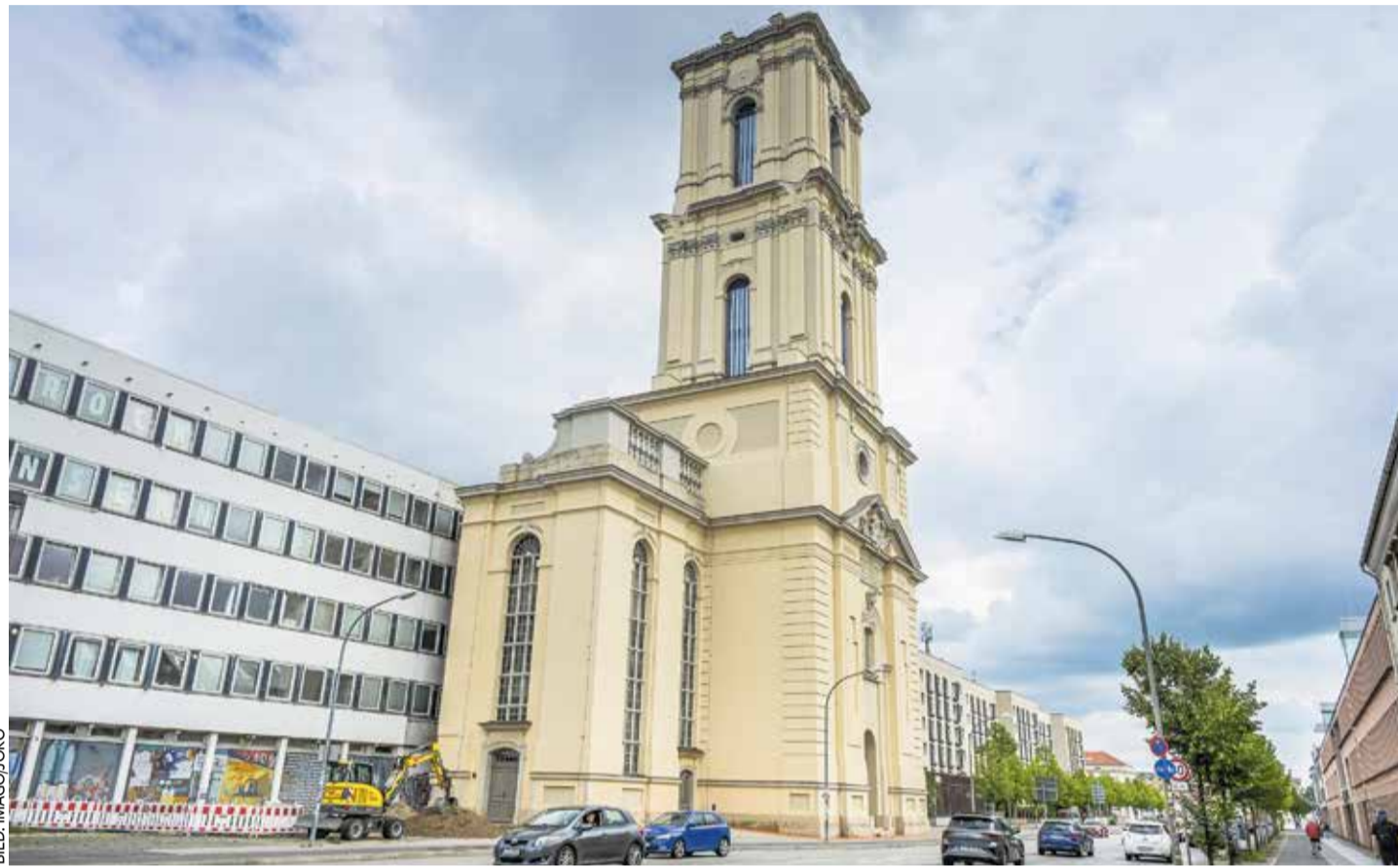
Architektonischer Widerspruch: Der wiederaufgebaute Turm der Garnisonkirche vor dem Rechenzentrum aus DDR-Zeiten
